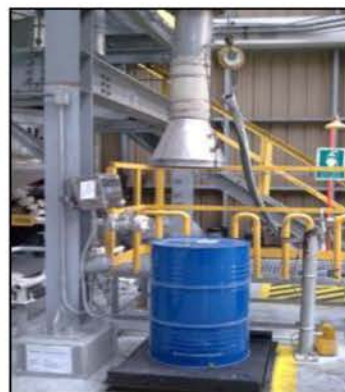
พัฒนาระบบปรับอากาศบริเวณสายสารเคมีจากถัง
